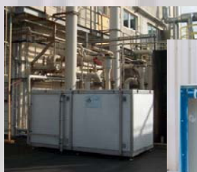
Unité d'oxydation catalytique 300 Nm 3 /h
