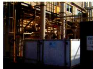
Unité modulaire sur site
